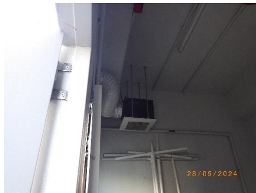
รูปที่ 2-24 ช่องดูดอากาศภายในห้องพักมุลลอย
