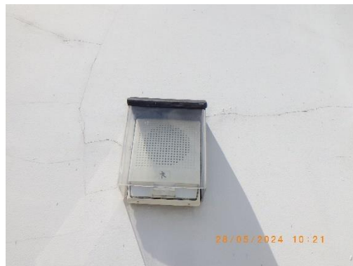
อุปกรณ์ส่งเสียงแบบกริ่งสัญญาณ
