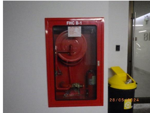
รูปที่ 2-30 ตู้เก็บสายฉีดน้ำดับเพลิงแต่ละชั้น
